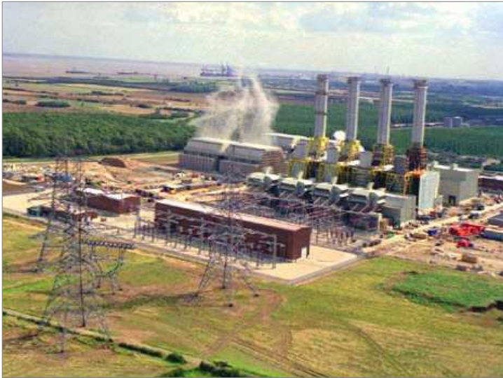
Transformador de alta tensión junto a una central
